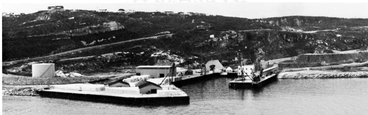
Baie-Comeau Dock No 2 – Anse du Moulin (5.179)
