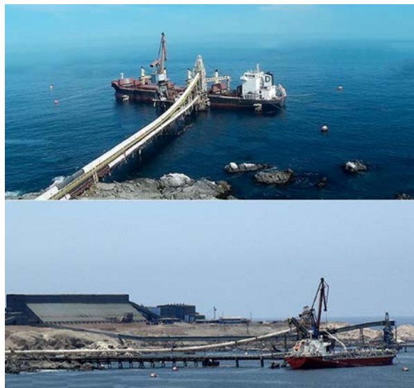
Punta Patache Terminal
