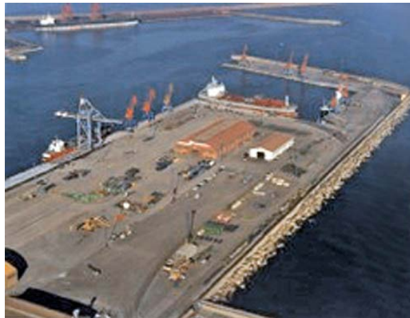
Gijón—Muelle de la Osa
