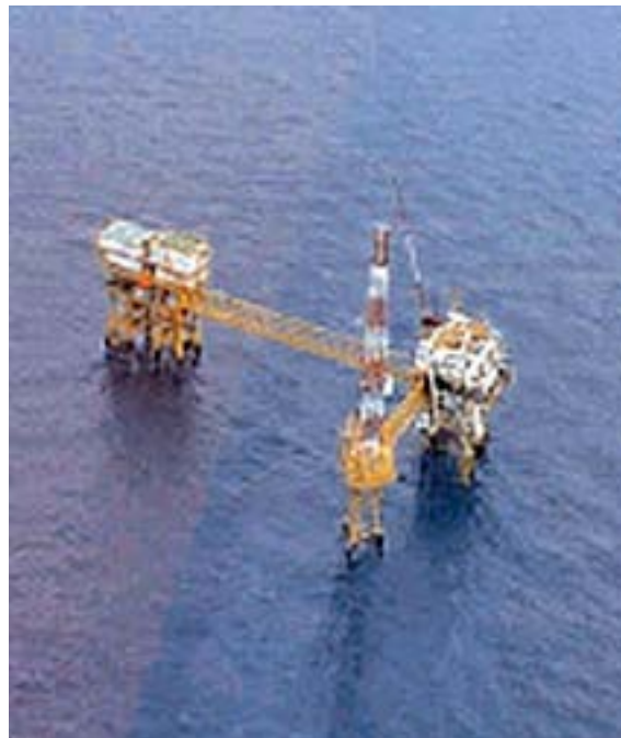
Cayo Arcas Platform
