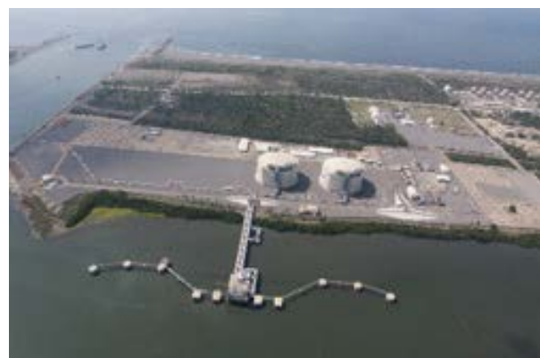
Manzanillo LNG Terminal
