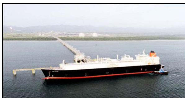
Caution Bay LNG Terminal
