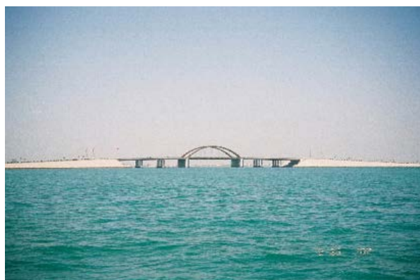
Mina Salman—Khawr al Qulayah Bridge
