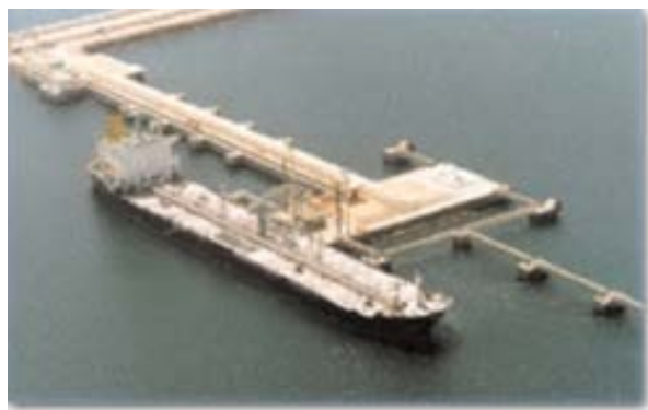
Ras Laffan—Liquid Products Jetty (Berth 2A/2B)
