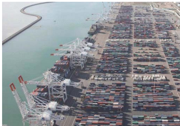
Le Havre (container terminal)
